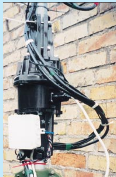
Bild 5: Die Speiseleitungen sind unter- sowie oberhalb des Rotors mit Kabelbindern zu fixieren, wobei auf eine ausreichende Drehreserve zu achten ist. Fotos: DL2RD (2)
